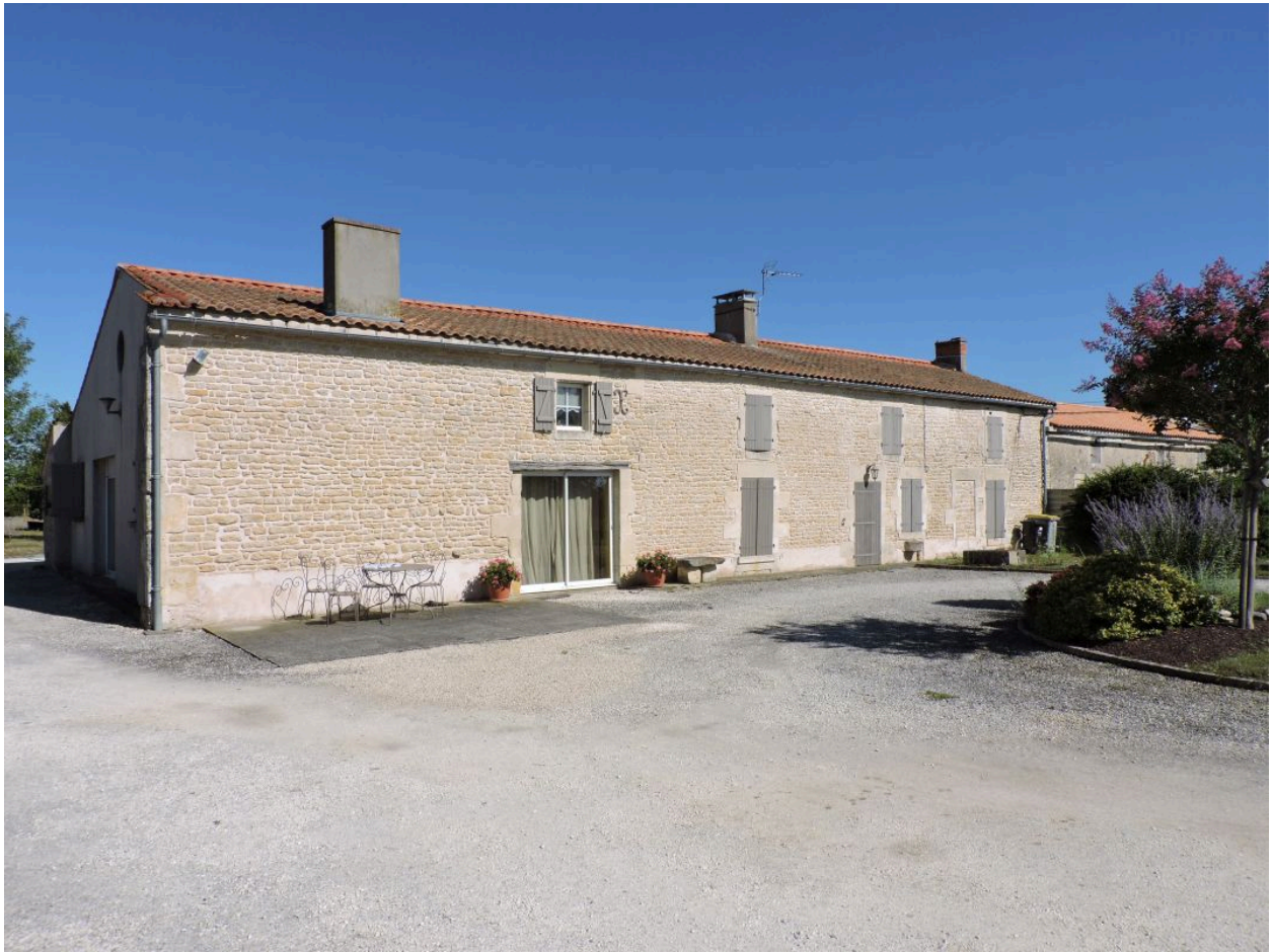
Le logis vu depuis le sud.
