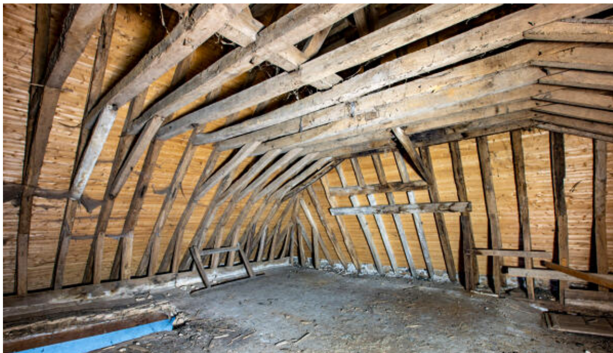
Le comble et la charpente.
