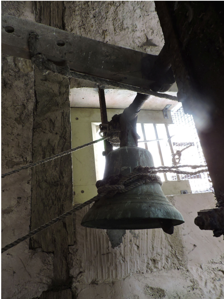
Cloche, vue d'ensemble.
