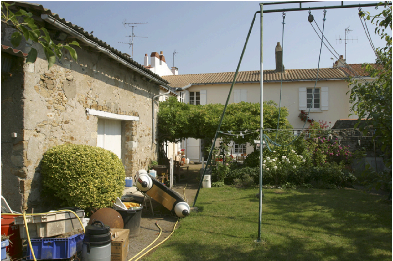
La façade postérieure vue depuis le jardin.
