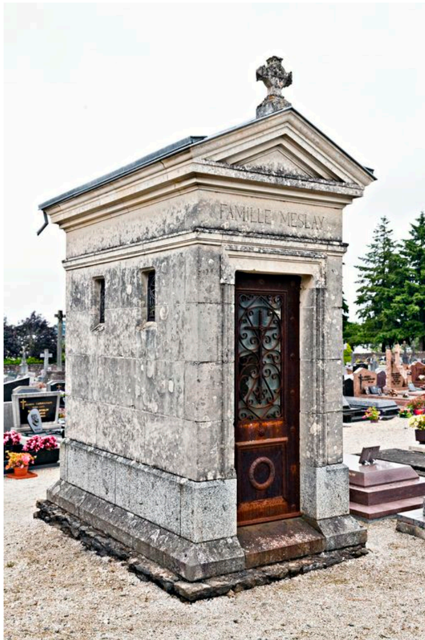
Vue d'ensemble de la chapelle.
