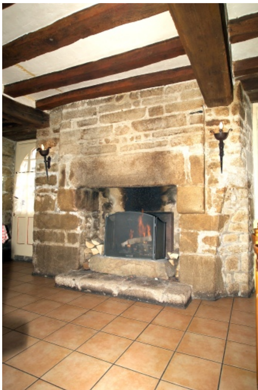
Cheminée au rez-de-chaussée de l'aile est.
