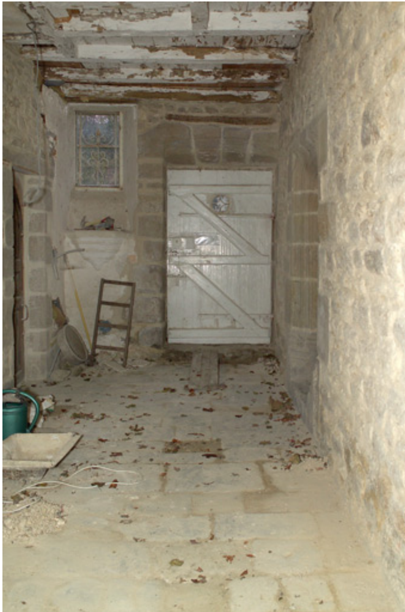
Rez-de-chaussée, couloir de distribution, revers de la porte sud.
