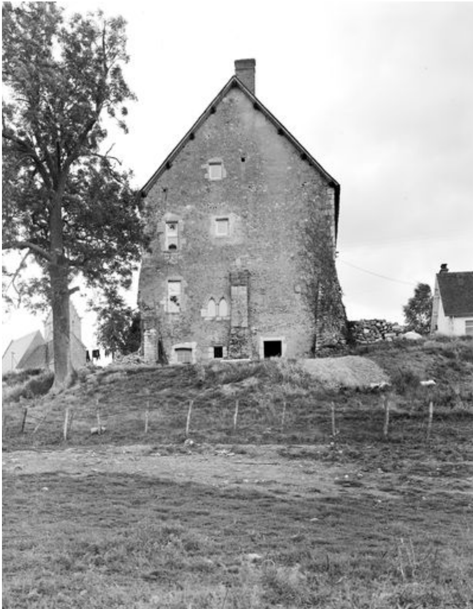
Le pignon nord-ouest, 1979.
