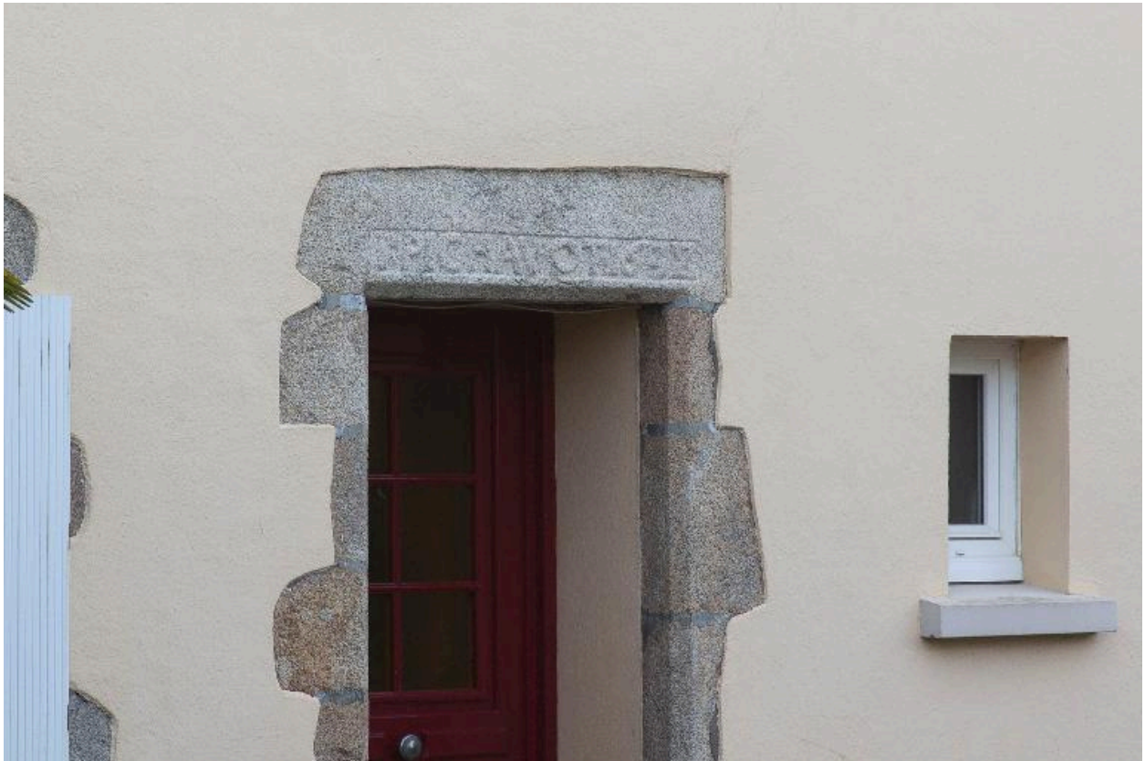
Porte de logis avec linteau en granite portant la mention "Pichavot 1622", ZR01-160, cadastre 2018
