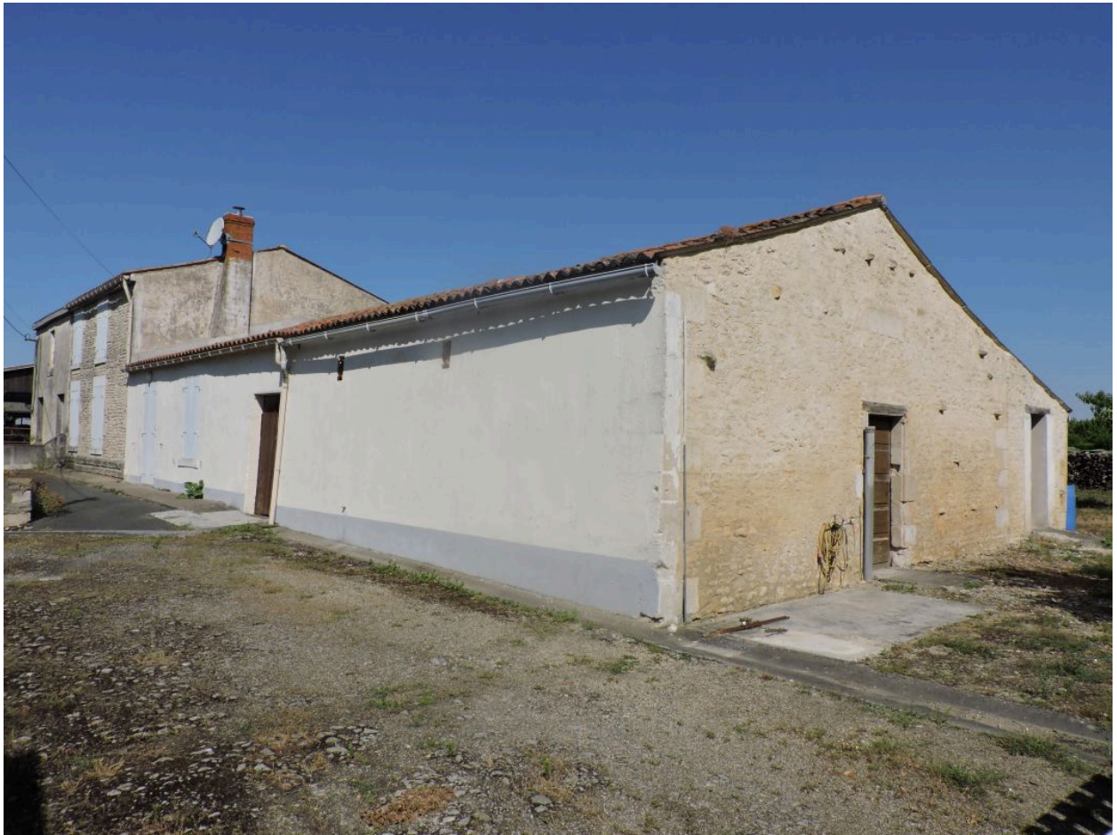
La grange-étable prolongeant le logis, vue depuis le sud-est.
