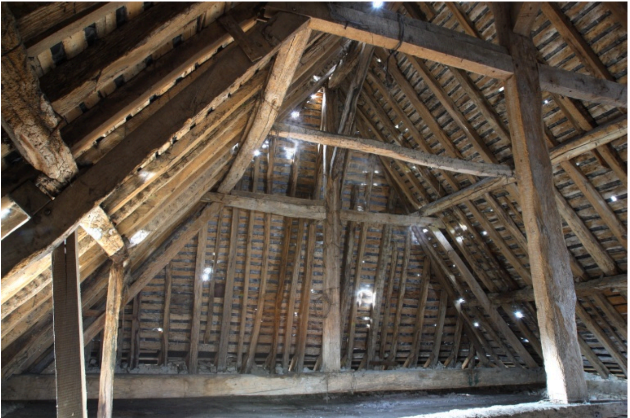
Comble du corps sud : la charpente vue depuis le nord.
