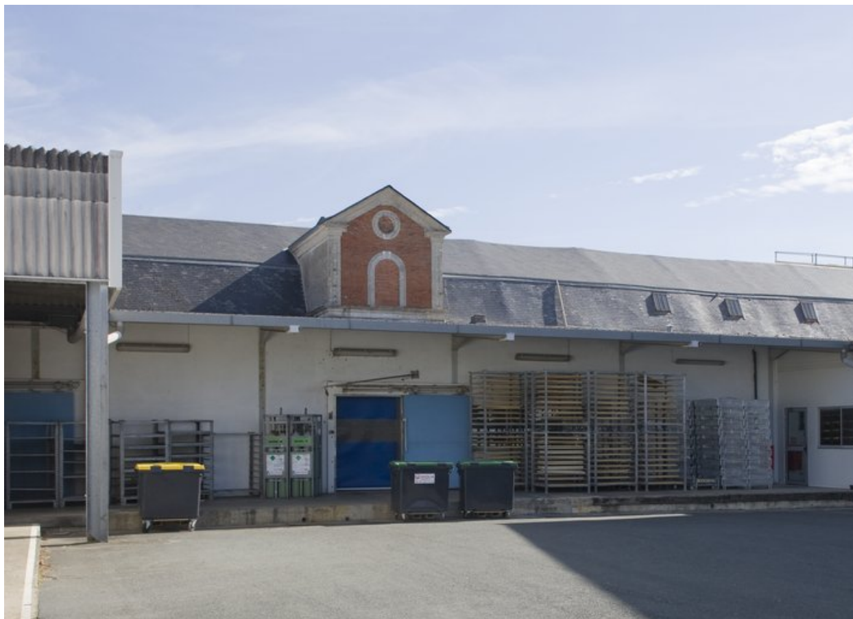
Vue partielle prise du sud.
