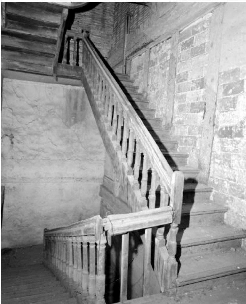
Couvent, aile nord-ouest, escalier en bois à balustres : vue d'ensemble.
