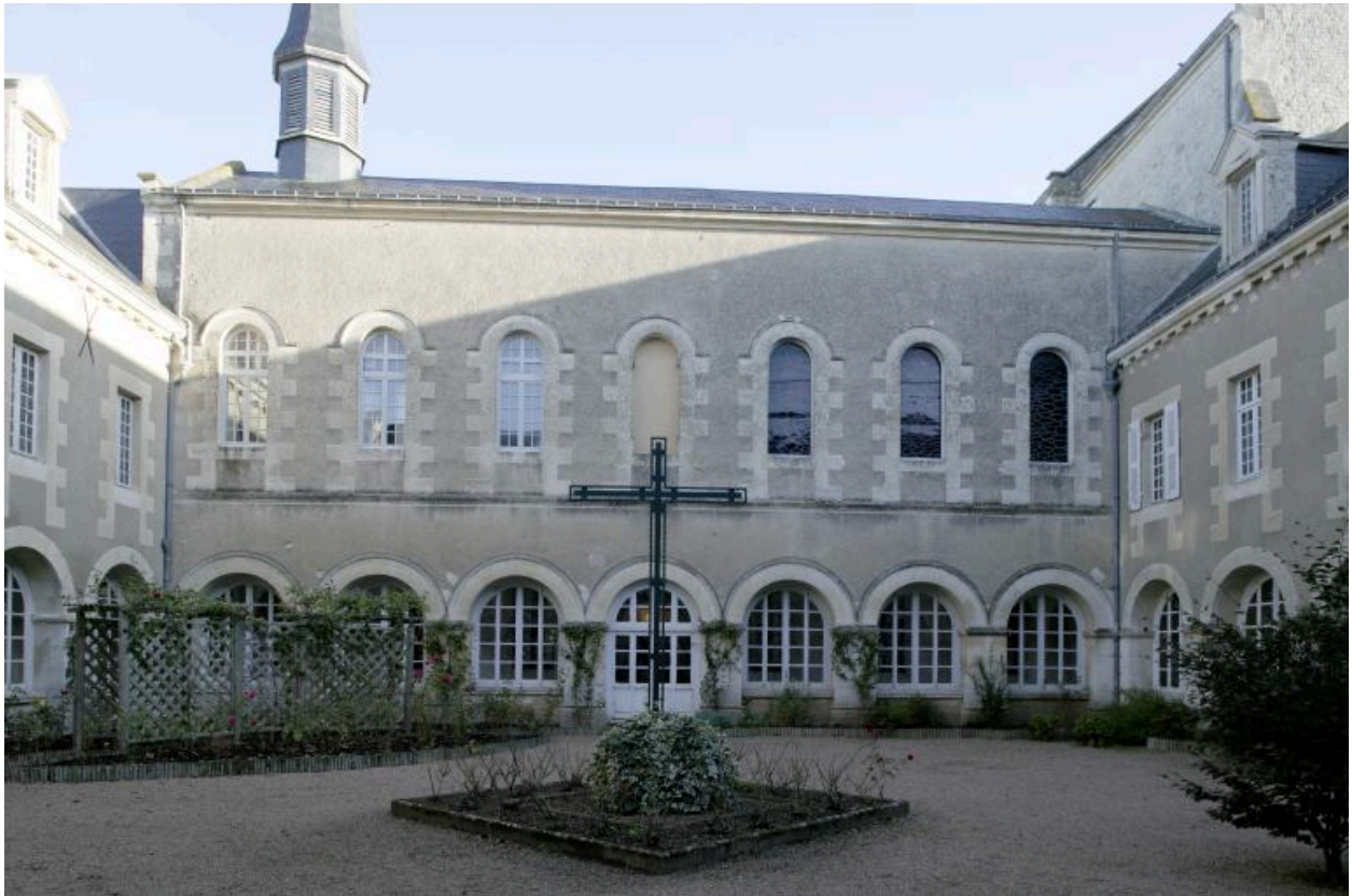
Vue des bâtiments conventuels, prise du sud du préau.
