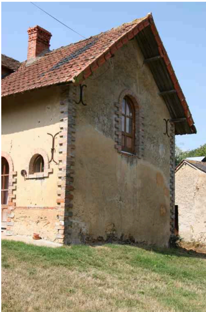
Maison n°5 du garde de la Rolitière : pignon.
