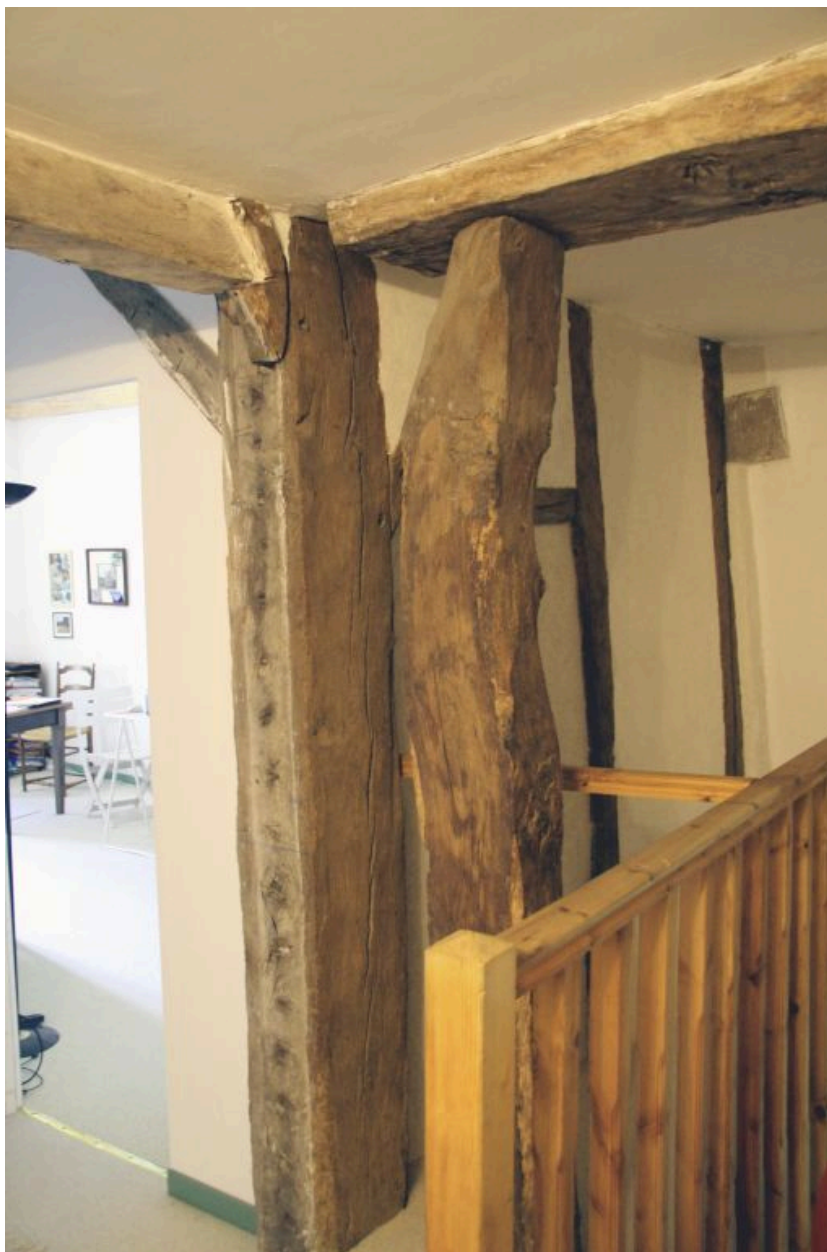
Le logis, 1er étage : poteau montant de fond (suite).
