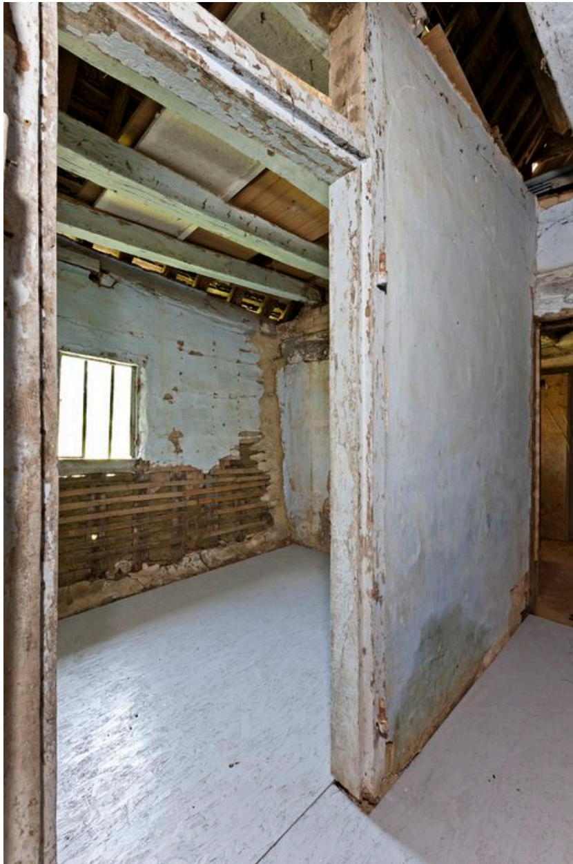
Vue intérieure du logis : laiterie.
