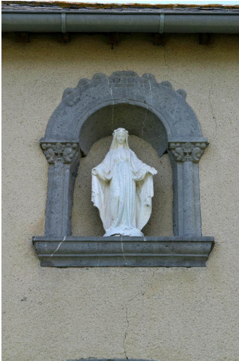
Détail de la façade principale du logis : la niche.
