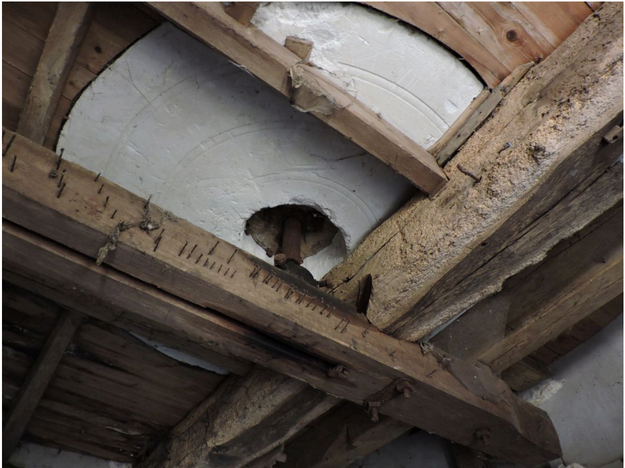
La meule, au premier étage, vue depuis le rez-de-chaussée.
