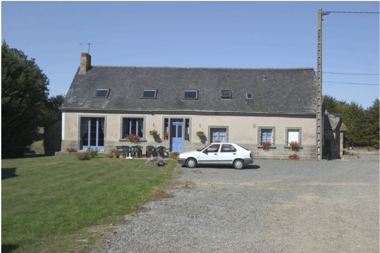
Le logis vu depuis le sud.
