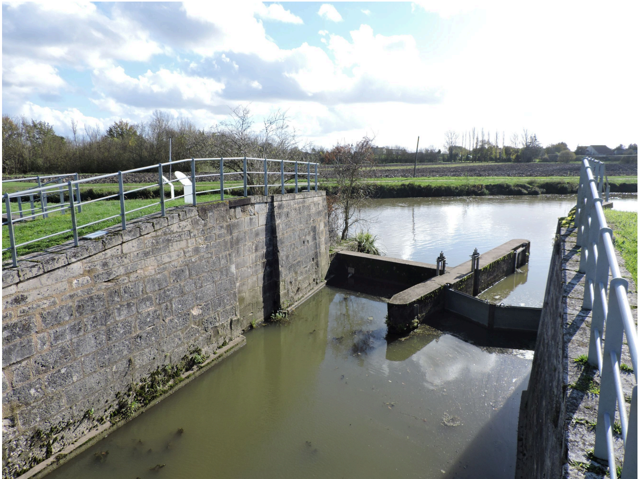
La Jeune Autise passant au-dessus de l'ancien aqueduc, en direction de l'aval.
