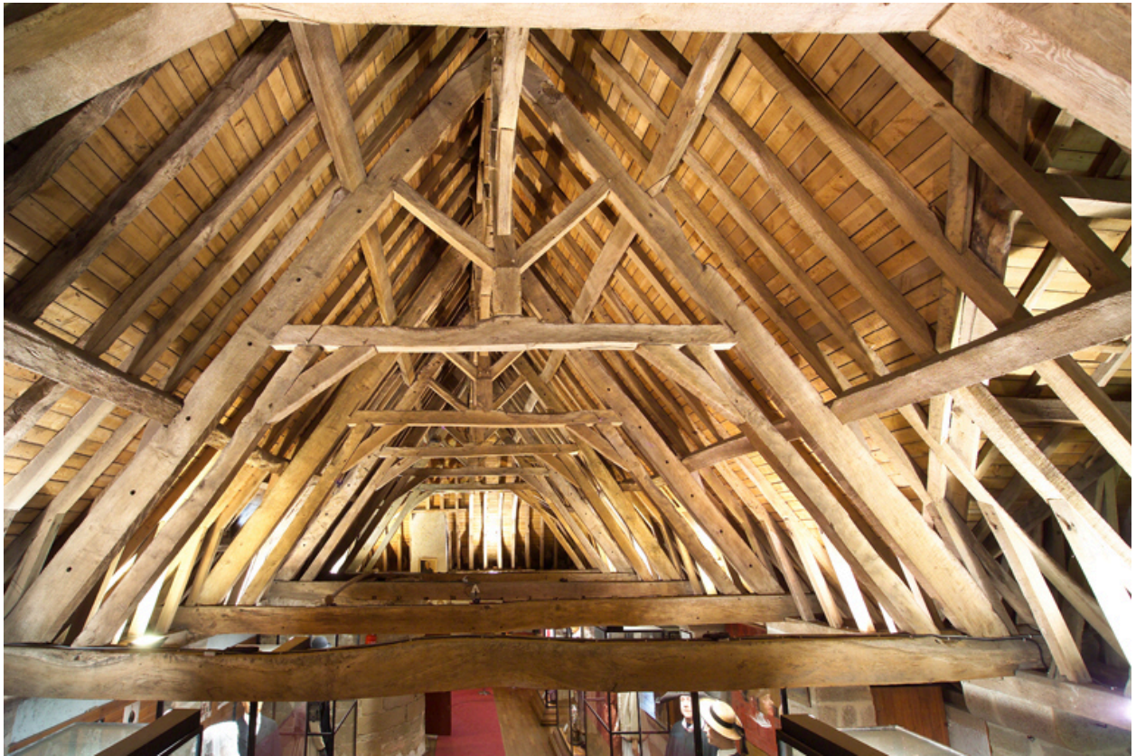
Vue de la charpente.
