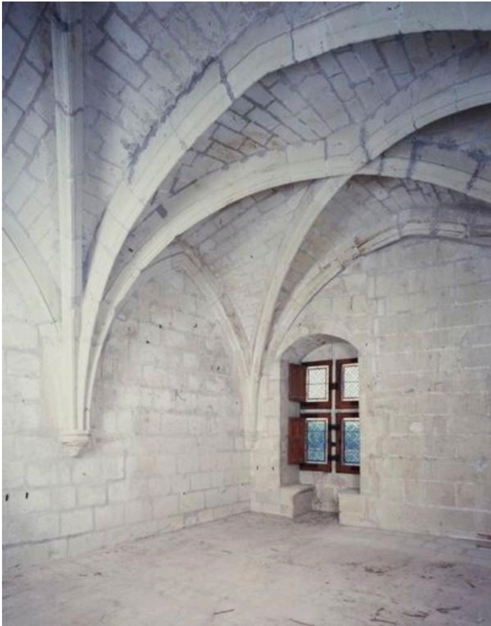
1er étage-carré : aile ouest de la tour ouest, garde-robe, angle nord-ouest.
