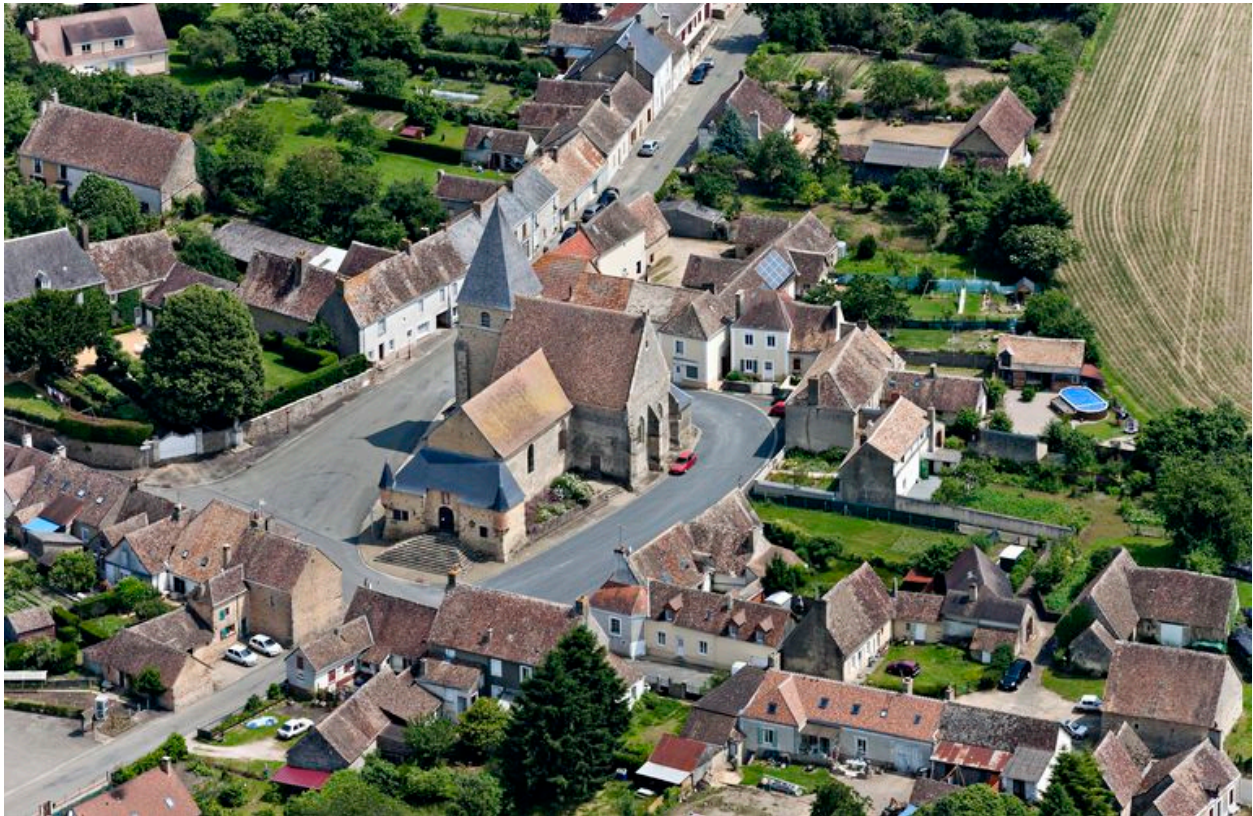
Vue aérienne des élévations postérieures depuis l'ouest (au premier plan).
