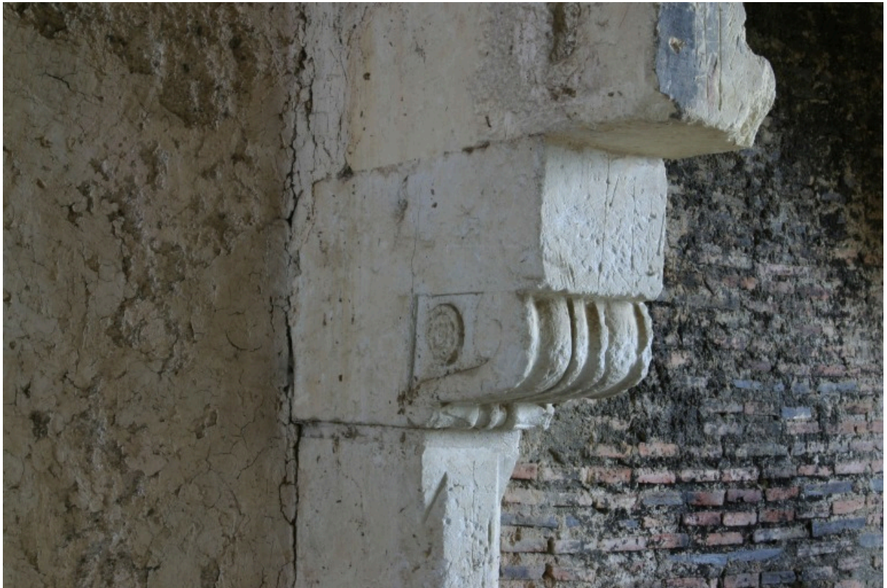
Rez-de-chaussée surélevé. Pièce 1B : le corbeau gauche de la cheminée.
