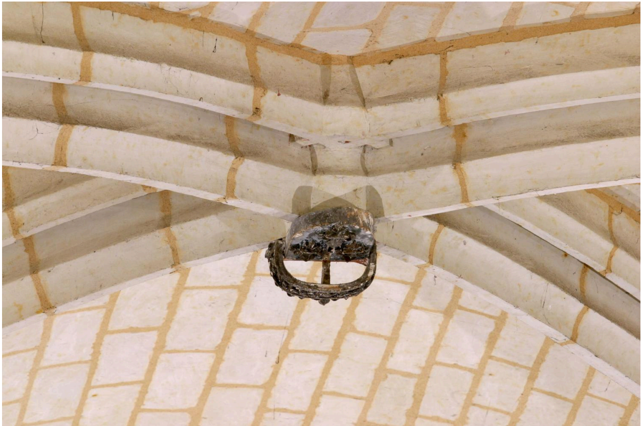
Chapelle Saint-Eloi. Deuxième travée : clef de voûte armoriée, vue depuis la tribune haute de la nef.
