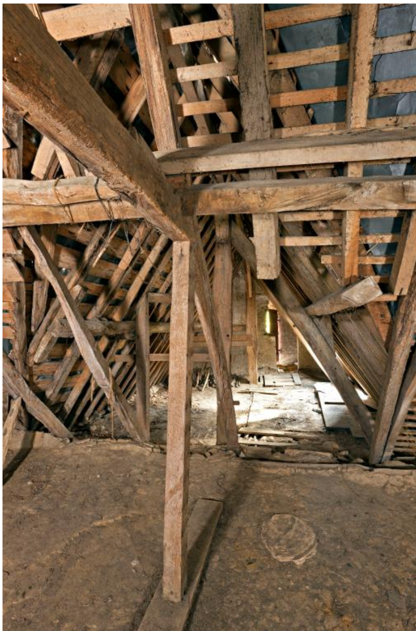
Vue depuis le comble de la maison 1 vers le comble de la maison 2.
