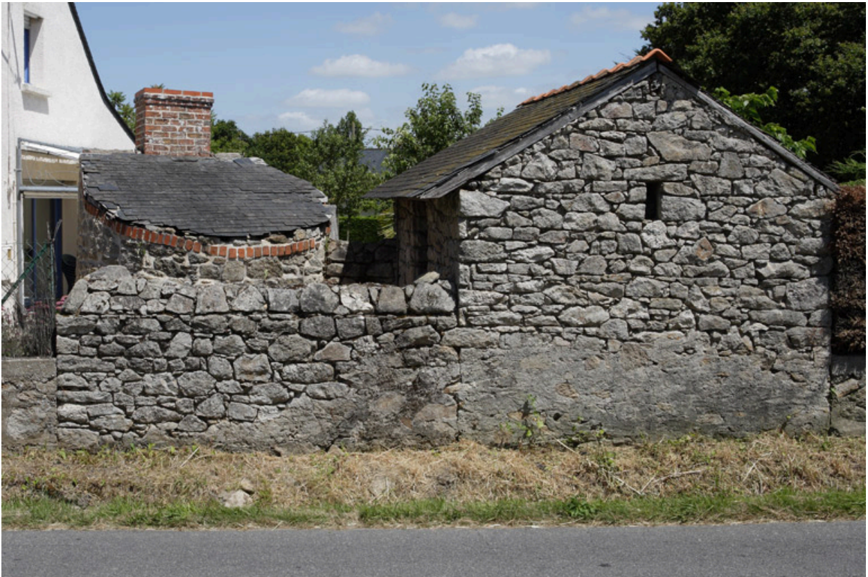
Vue du four à pain et de l'étable.
