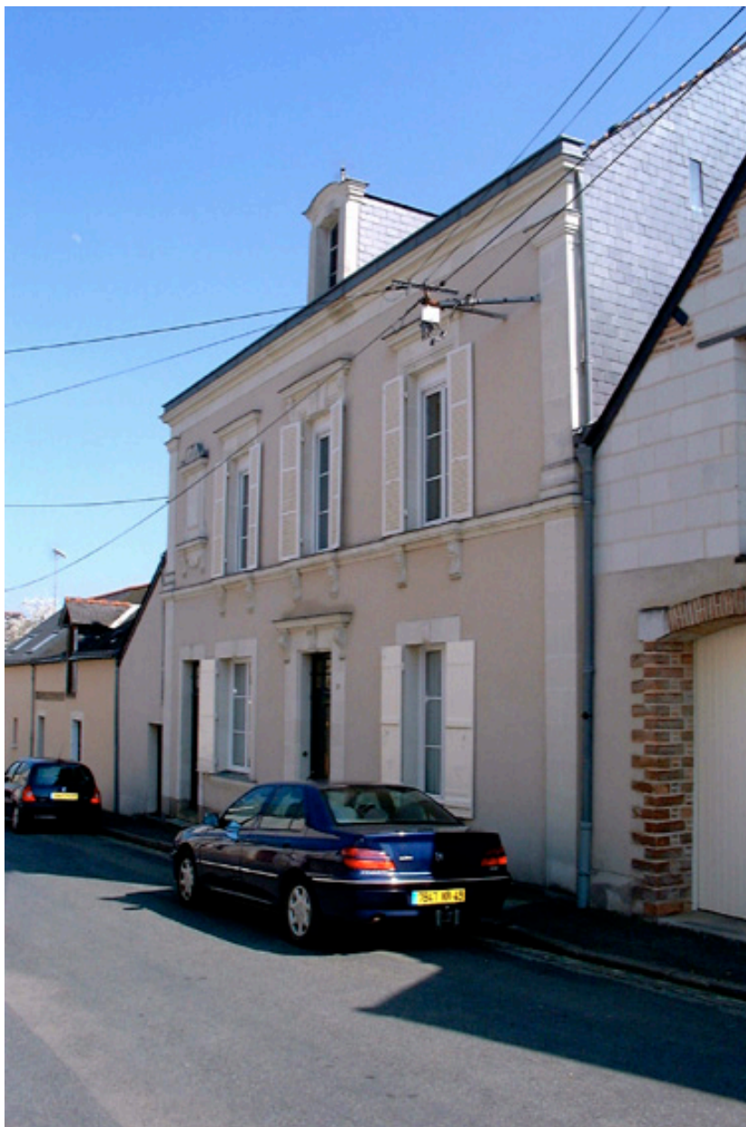
Maison à étage carré et façade ordonnancée.
