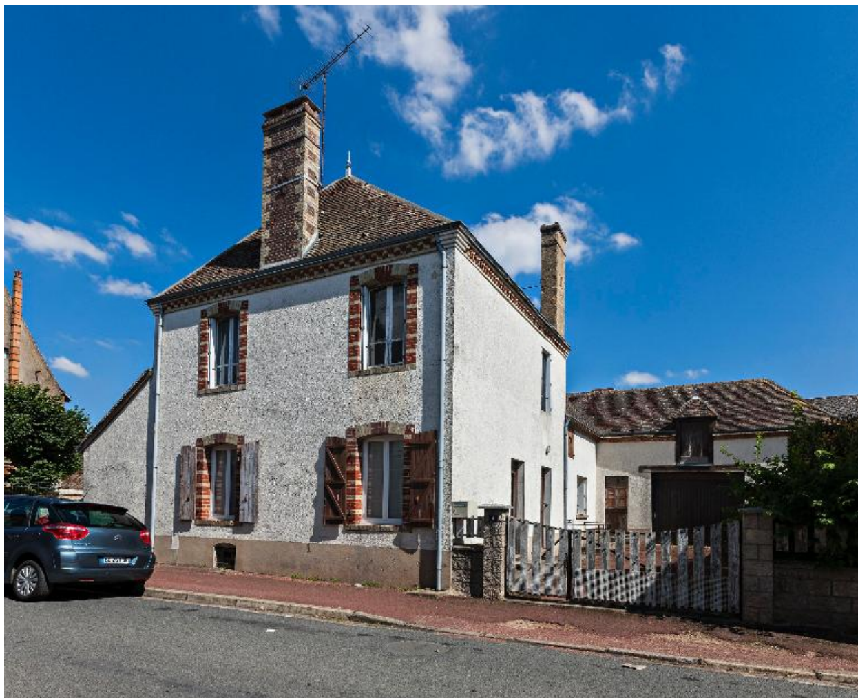
4, rue de la Poste. Maison. Mur pignon transformé dans le 2e quart du XXe siècle.
