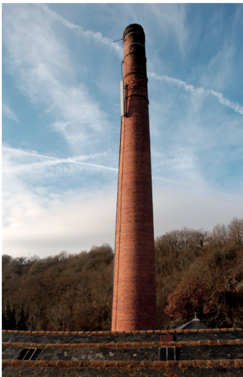
La cheminée de la chaufferie.
