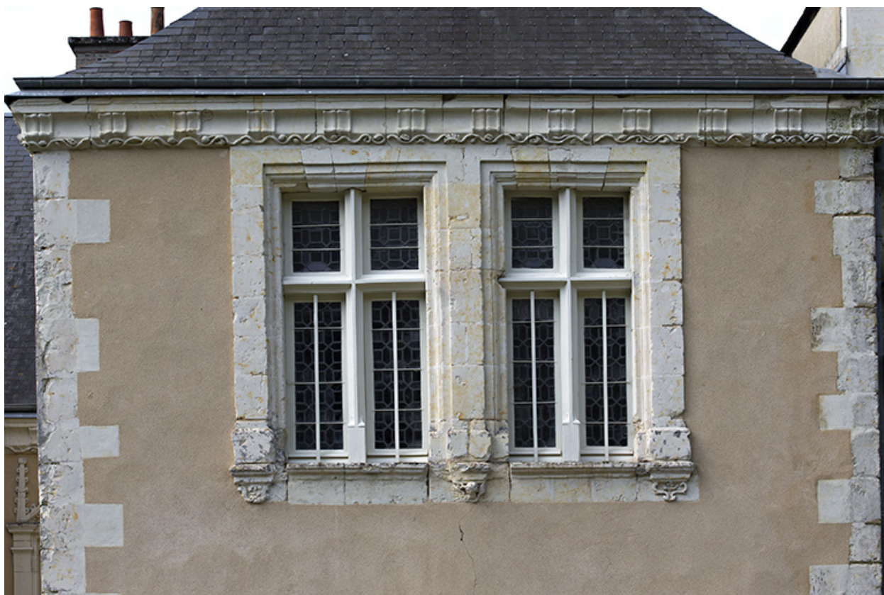
Elévation nord, pavillon d'escalier, détail de l'étage.
