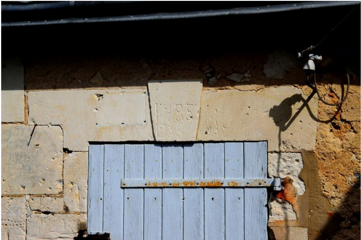
Le moulin, habitation : linteau daté 1788.
