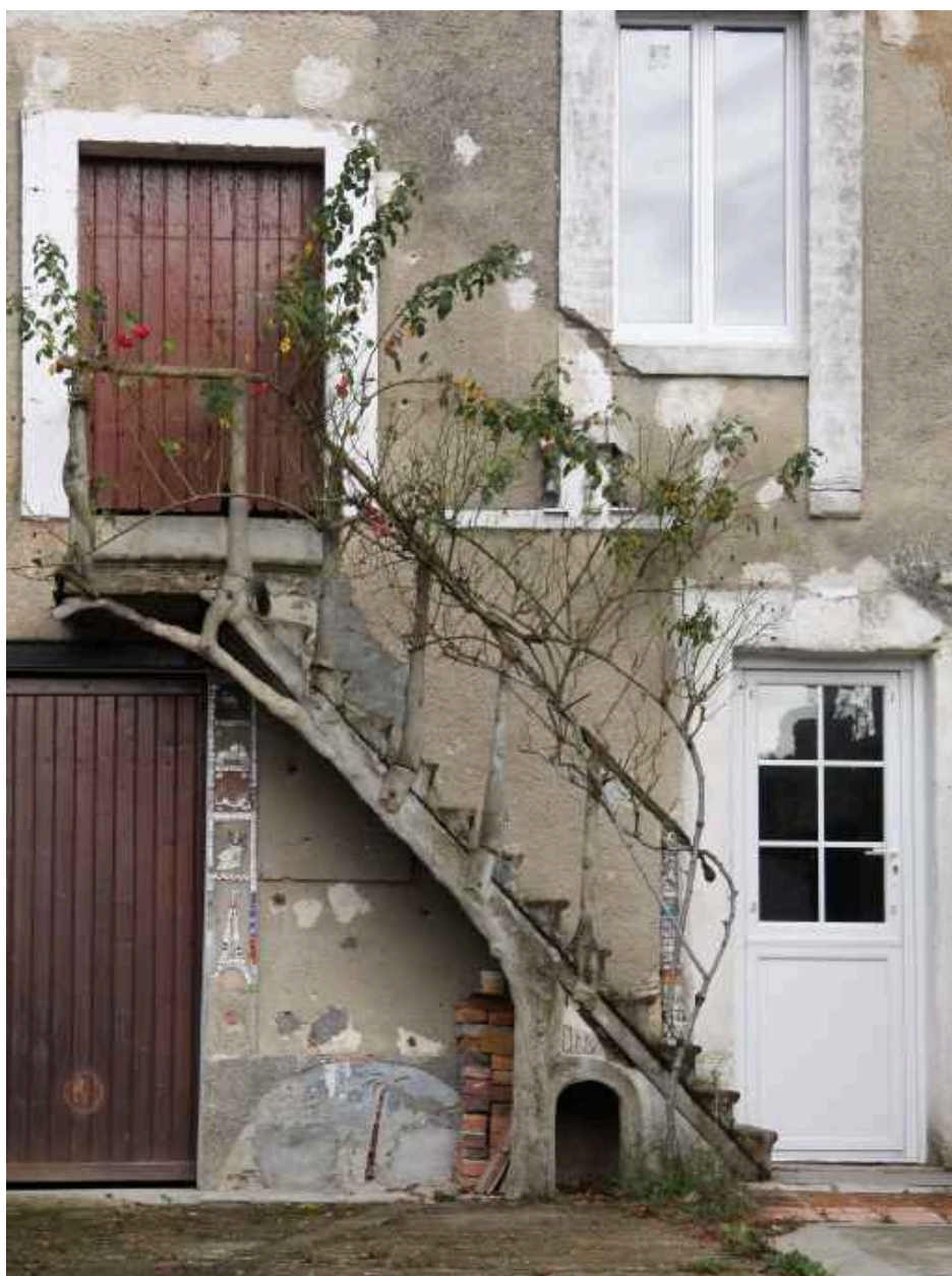
Façade antérieure : escalier hors œuvre.
