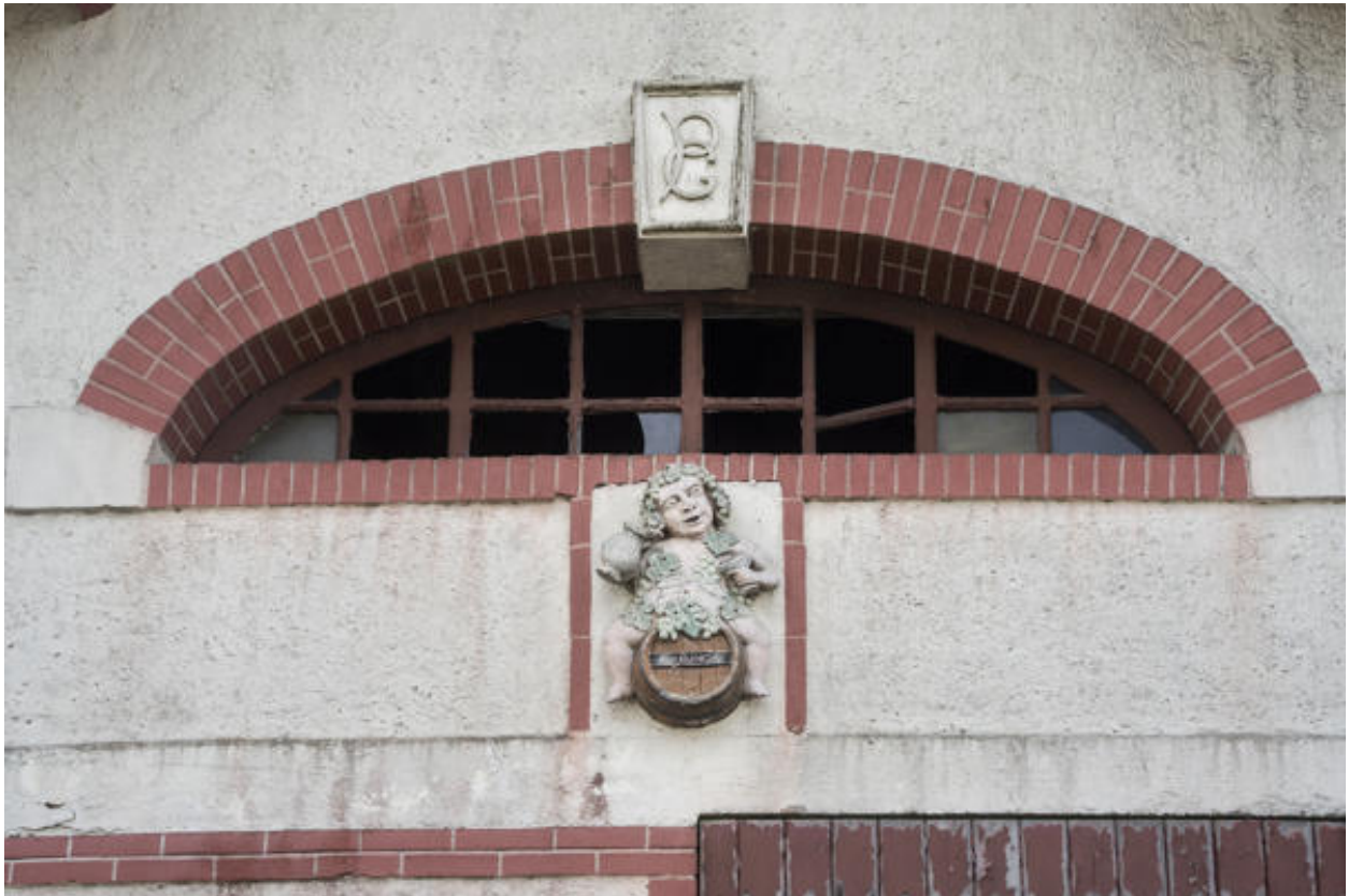
Baie en surplomb de la façade principal du bâtiment primitif, site de la rue des Rosiers.
