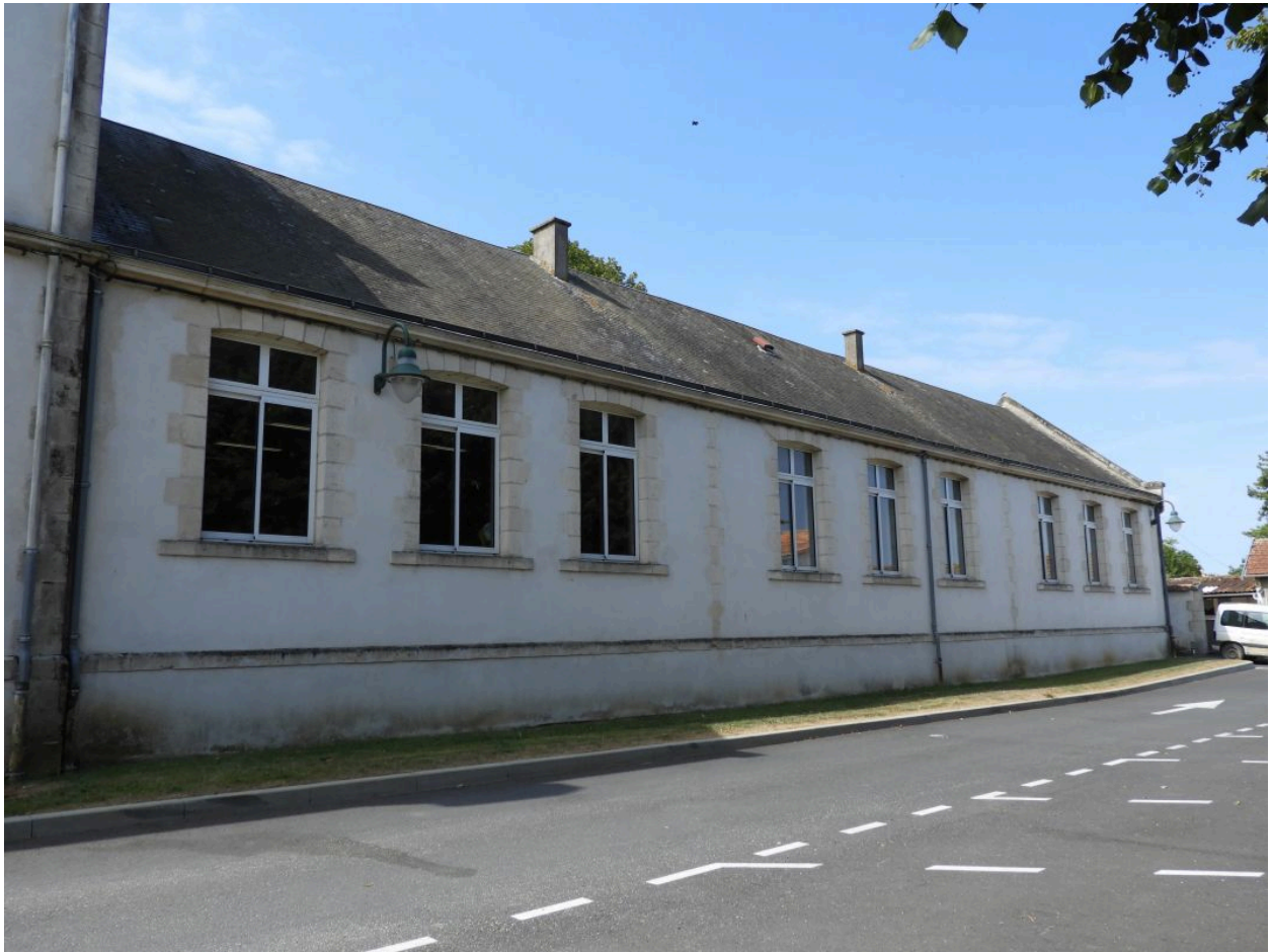
L'aile ouest de salles de classe vue depuis le nord-est, côté place.
