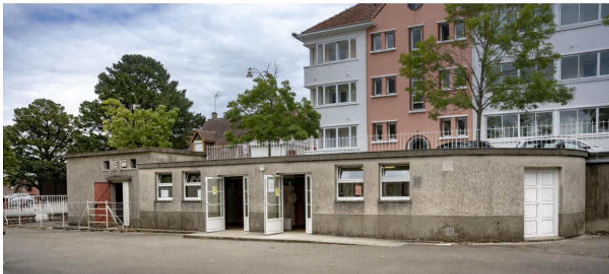
Vue du bâtiment des sanitaires dans la cour de l'école.
