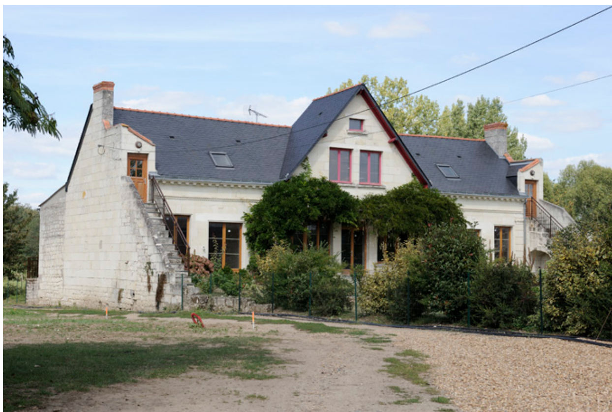
Maison du 35, rue du Port, vue d'ensemble du bâtiment principal.
