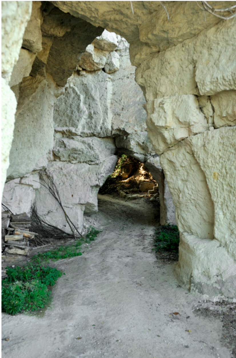
Site principal (11-16, ruelle des Perreyeurs). Fontis ouest. Une entrée de la carrière de la Maumènière (ruelle des Perreyeurs, cadastre 2011 E 142).
