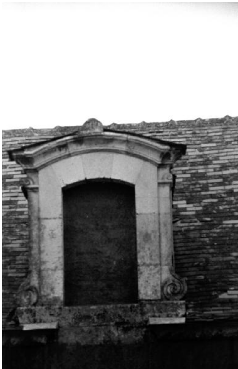
Détail d'une lucarne, corps principal du presbytère.
