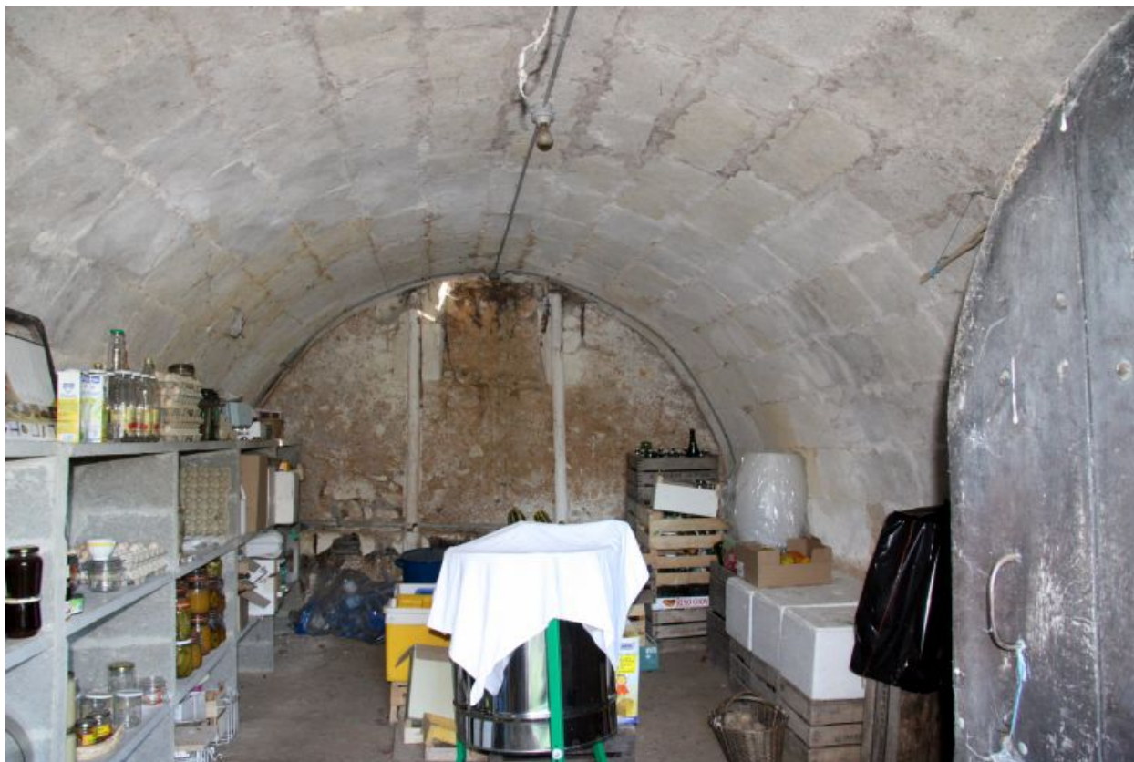
Cave voûtée dans le sens transversal, sous la maison .
