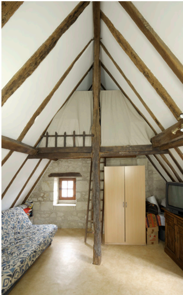
Comble : vue d'ensemble de la charpente.
