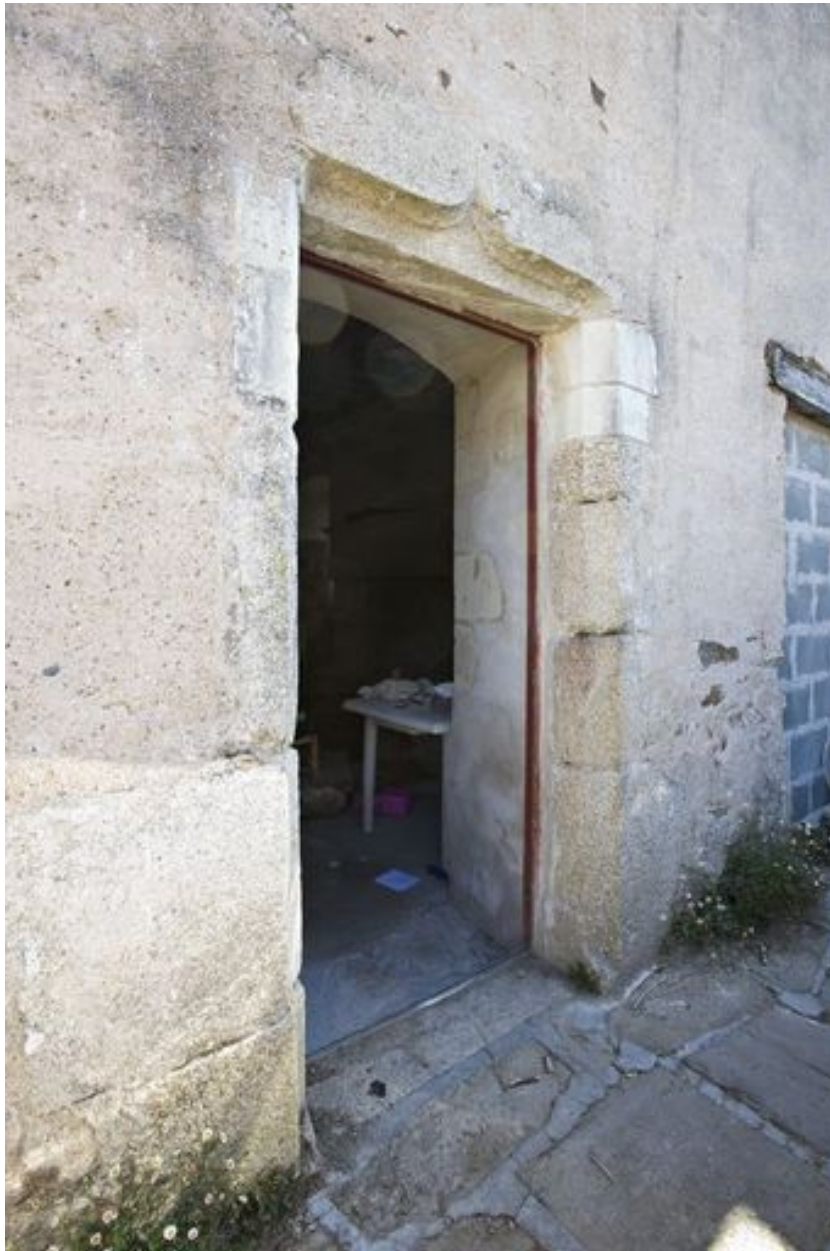
Elévation sud : porte avec linteau à accolade.
