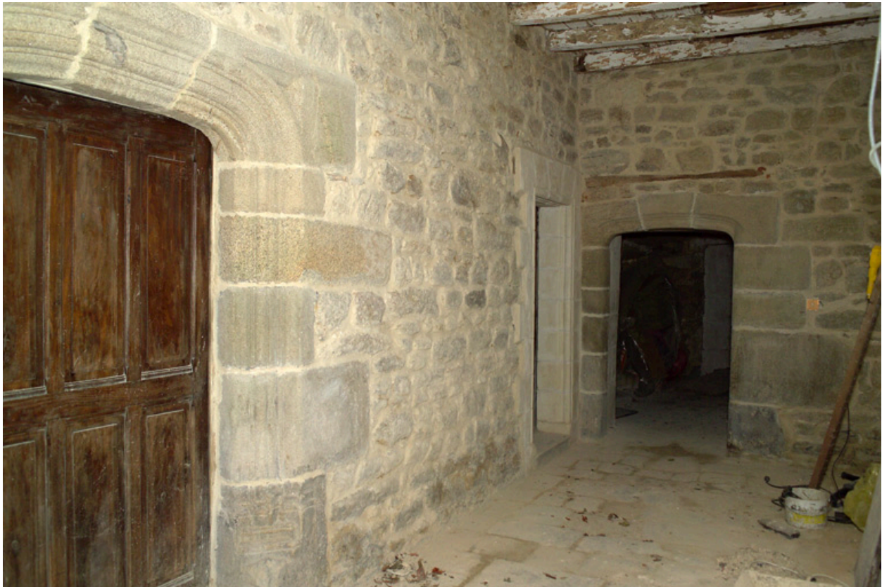
Rez-de-chaussée, couloir de distribution, portes ouest et, au nord, vers l'escalier en vis.
