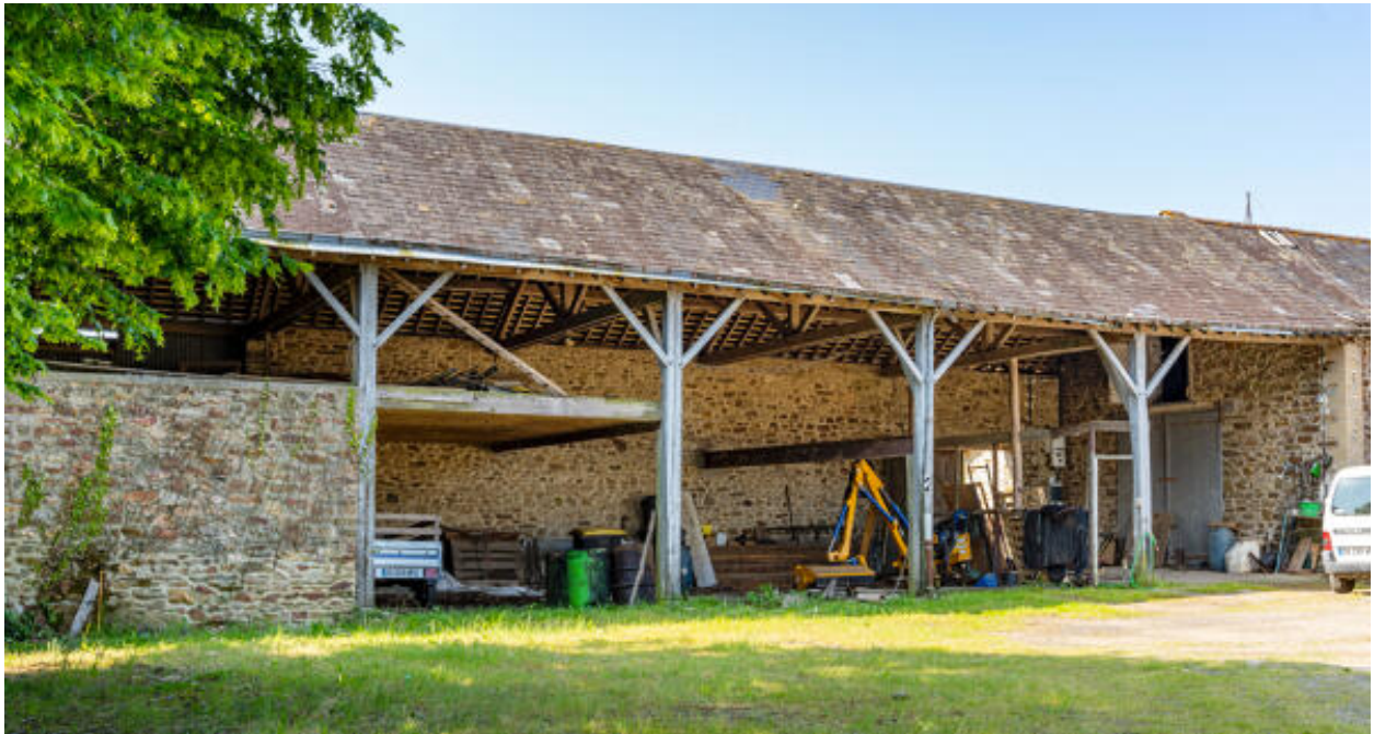
Le hangar à poteaux.
