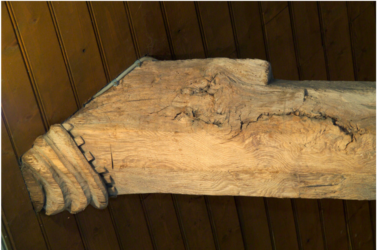
Charpente à engoulant (détail).
