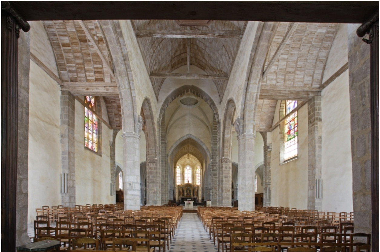
Nef et collatéraux restaurés vue d'ensemble vers le chœur.
