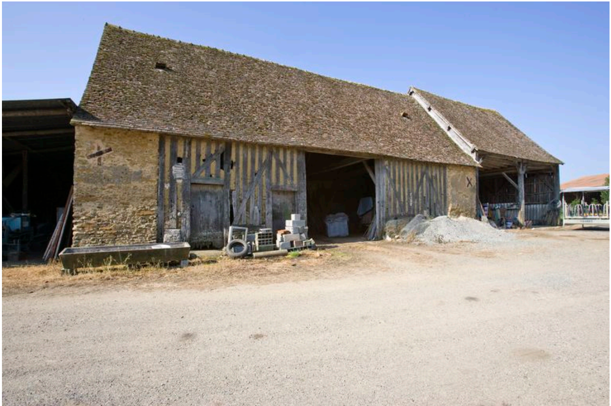
Grange-étable avec remise accolée.
