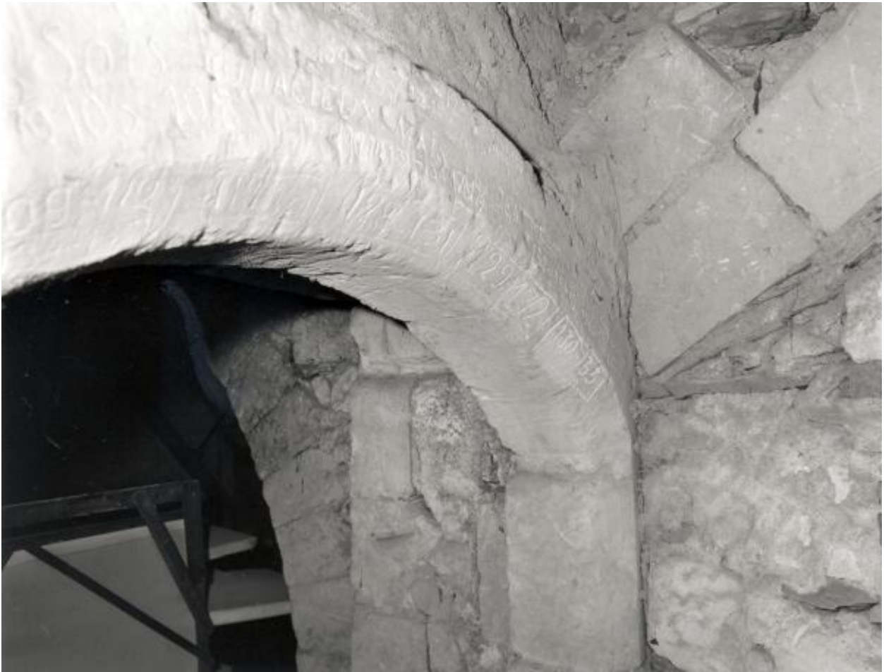
Aile ouest du cloître, rez-de-chaussée à usage de communs, mur sud au contact de la descente de cave, porte ouest : détail de la plate-bande.
