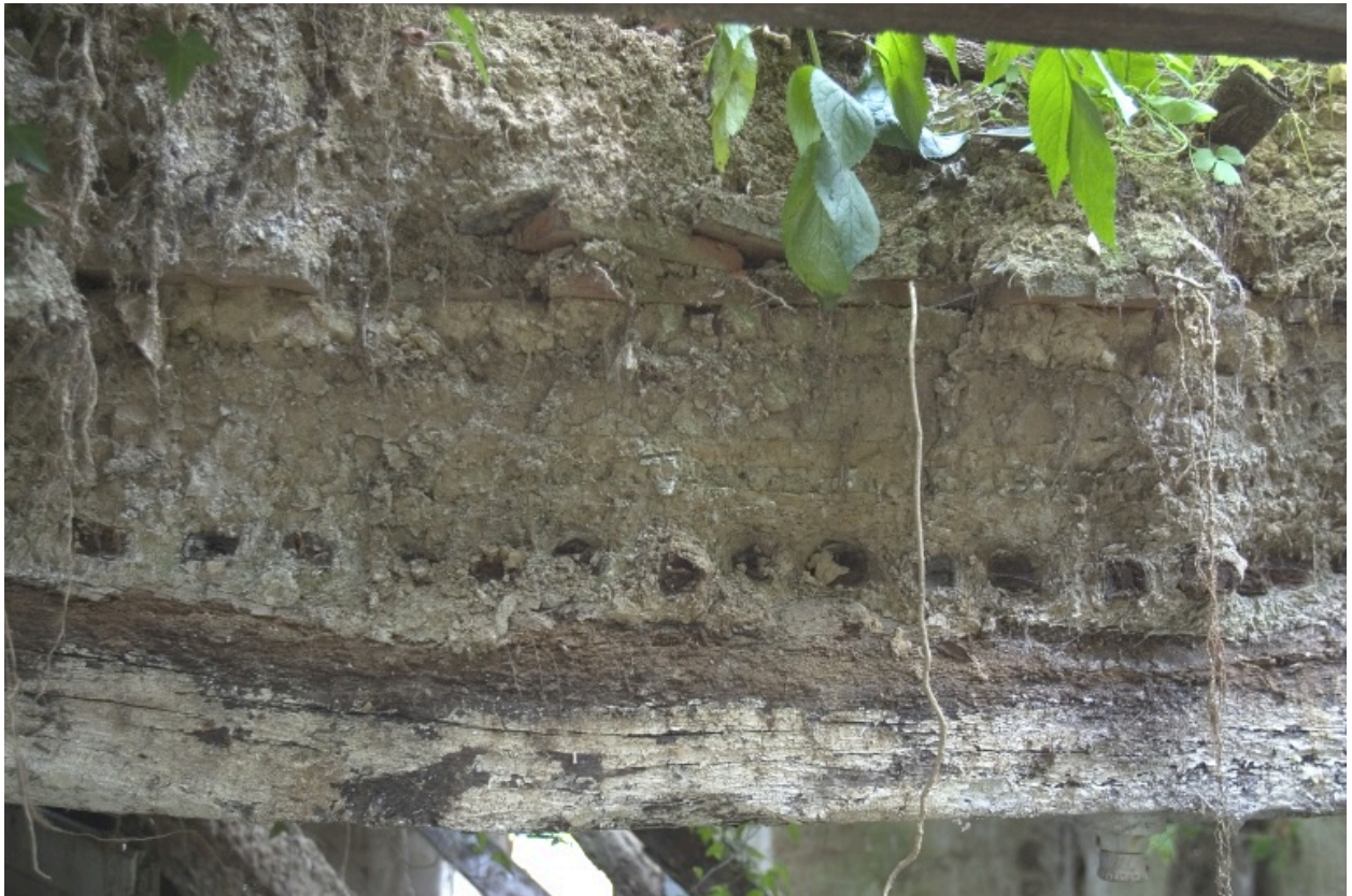
Intérieur du logis, rez-de-chaussée, chambre sud-est : coupe du plancher.
